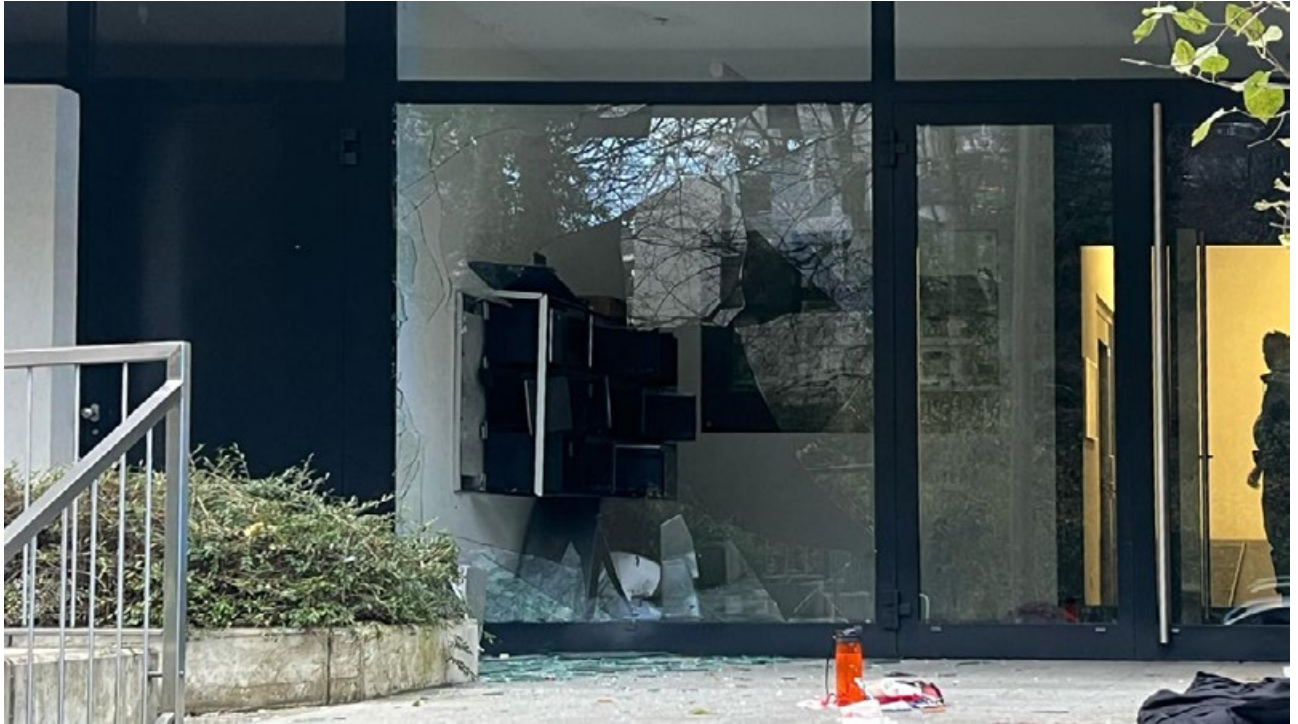
Un engin explosif a détoné dans le hall d'entrée d'un immeuble résidentiel à Genève.
